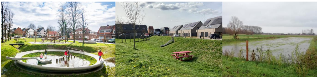
Figuur 27. Bovenlokale buffers kunnen meerdere functies combineren. Links en midden wordt de bufferfunctie gecombineerd met een recreatieve functie, waar de foto rechts infiltratie en buffering combineert. Locatie: (links) Kontich, (midden) Kortrijk en (rechts) Kruisem. © Aquafin
