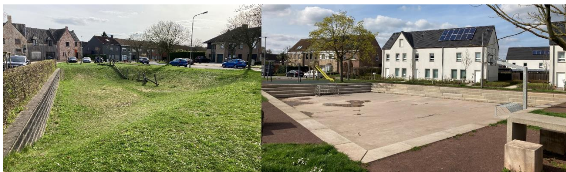
Figuur 8. Voorbeelden van buffervoorzieningen: (links) verlaagde groen-/speelzone (Kortrijk) en (rechts) verlaagd aangelegd basketbalplein (Kortrijk). © Aquafin
