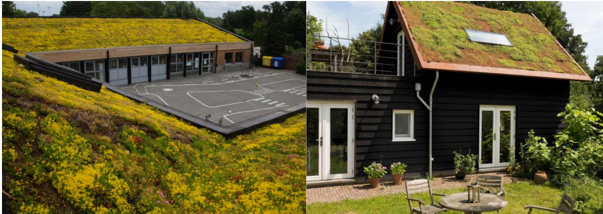
Figuur 32. Voorbeelden van een groendak. Links wordt een groendak toegepast op een groot, weinig hellend dak van de basisschool in Meerdonk Sint-Gillis-Waas. Rechts is het toegepast op het dak van een privé woning. Bron: Blauwgroen Vlaanderen.
