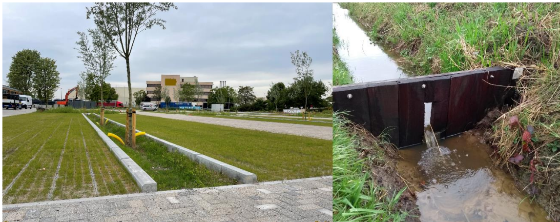
Figuur 4. Voorbeelden van mogelijke maatregelen om afstroom te vermijden van (links) verharde oppervlaktes (parking Aquafin, Aartselaar) en (rechts) in een afvoergracht via een (knijp)stuw (Maldegem). © Aquafin
