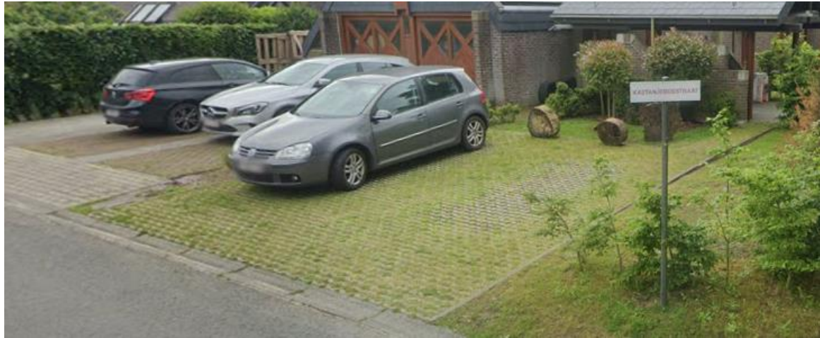
Figuur 31. Oprit/voortuin in halfverharding in de Kastanjesbosstraat in Jabbeke. Bron: Google Maps.
