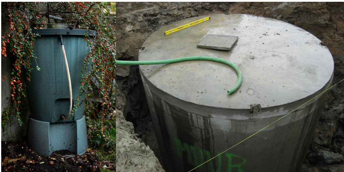
Figuur 5. (Links) regenwaterton en (rechts) regenwaterput. © Aquafin
