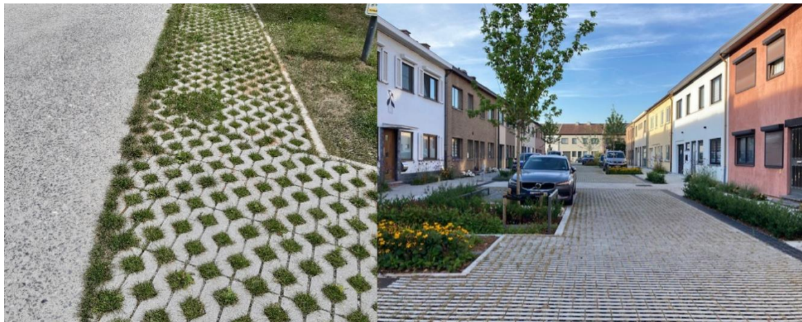
Figuur 18: Vlnr: (1) Versmald voet-fietspad met uitwijkmogelijkheid over waterdoorlatende verharding (Overijse). © Aquafin; (2) Tuinstraat met zowel rijweg als parkeervakken aangelegd in halfverharding (Aziëlaan, Wilrijk). © Aquafin.
