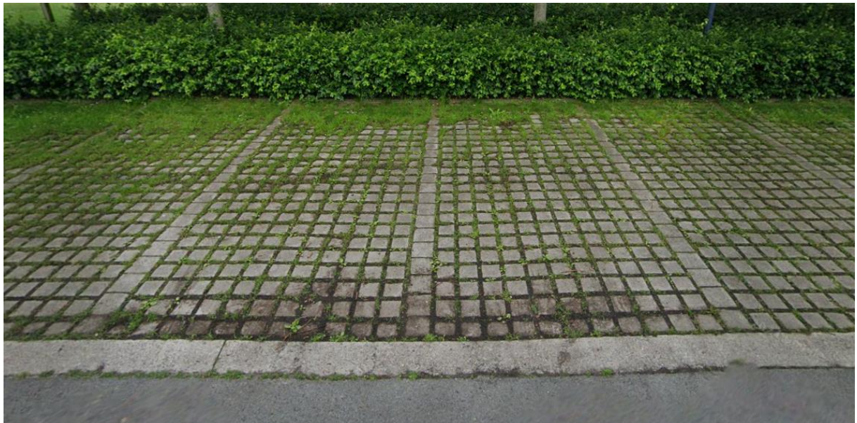
Figuur 22. Voorbeeld van de toepassing van halfverharding voor parkeervakken, toegepast voor de parking van het Vrijtijdscentrum van Jabbeke (Vlamingveld). Bron: Google Maps.
