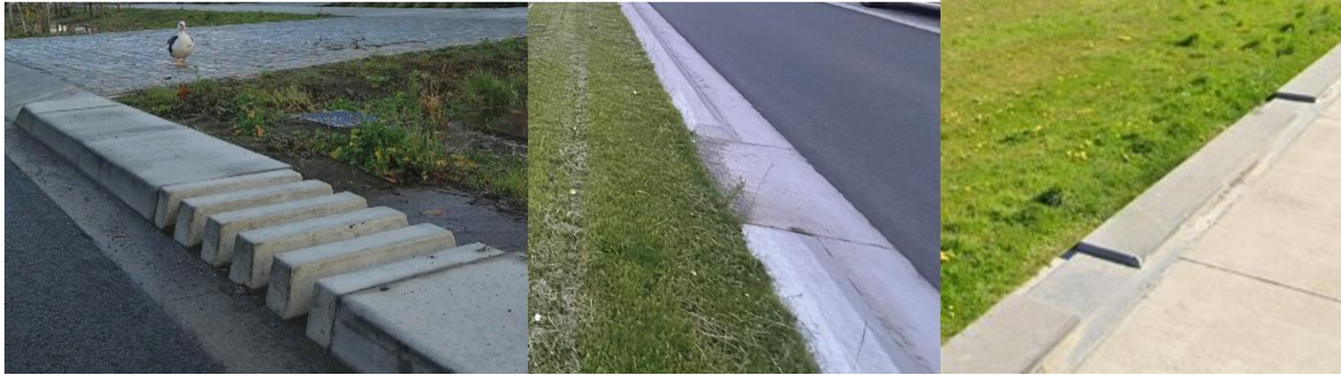
Figuur 25. Voorbeelden van een boordstenen met spleten: (links) in de Fortstraat in Mortsel. Bron: dbpubliekeruimte.info, (midden) in Catershoflaan in Merksem © Aquafin en (rechts) in de Krakeelhoevestraat in Kortrijk. Bron: Google Maps.
