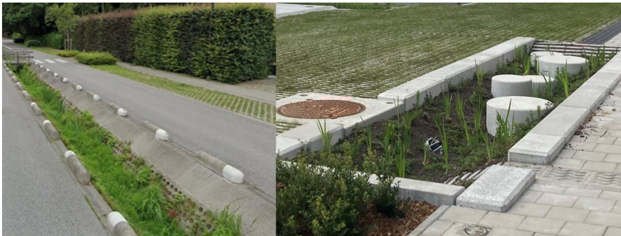
Figuur 16. Voorbeelden van hoe hemelwater kan worden geïntegreerd in het straatbeeld. Links) gracht tussen twee rijstroken in de Magdalena Vermeerschlaan (Hove); Rechts) verlaagd plantvak in Aziëlaan (Wilrijk).
