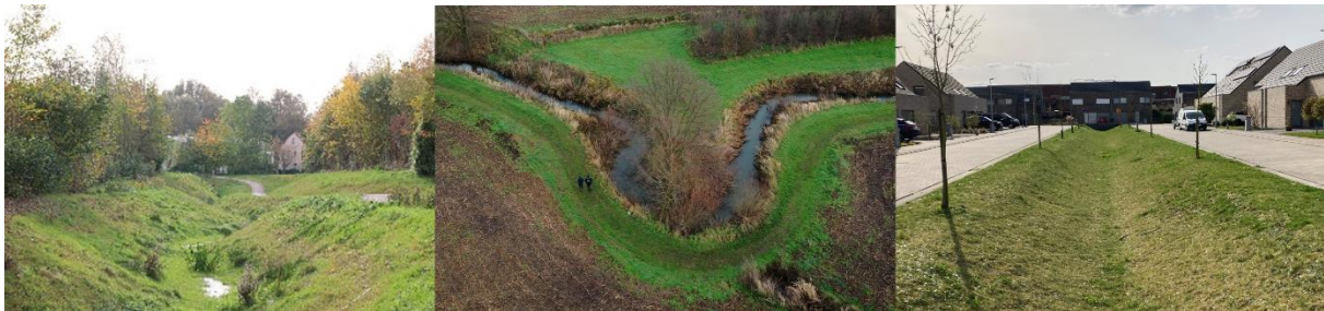
Figuur 29. Blauwgroene afvoerwegen bieden een breed spectrum aan inrichtingsmogelijkheden. (Links) Vuilbeek te Wezembeek-Oppem als blauwgroene verbinding ©VMM; (midden) meanderende beek met bufferstroken ©VMM; (rechts) verlaagd aangelegde groenzone in een woonwijk in Kortrijk © Aquafin.
