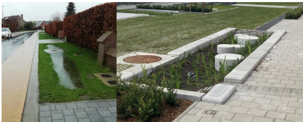
Figuur 20. (Links) Infiltratiekom langs de straat (Kruisem); (Rechts) Bufferend plantvak (Aziëlaan Wilrijk, tuinstraat). © Aquafin.
