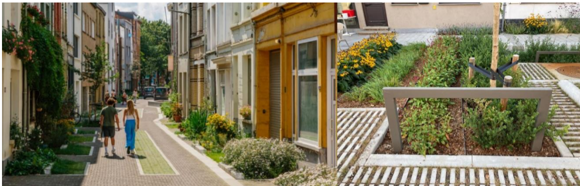
Figuur 19. Vlnr: (1) Ontharding met boven- en ondergrondse infiltratie in centrum Antwerpen; (2) Infiltrerende plantvakken in Aziëlaan (tuinstraat Wilrijk). © Aquafin
