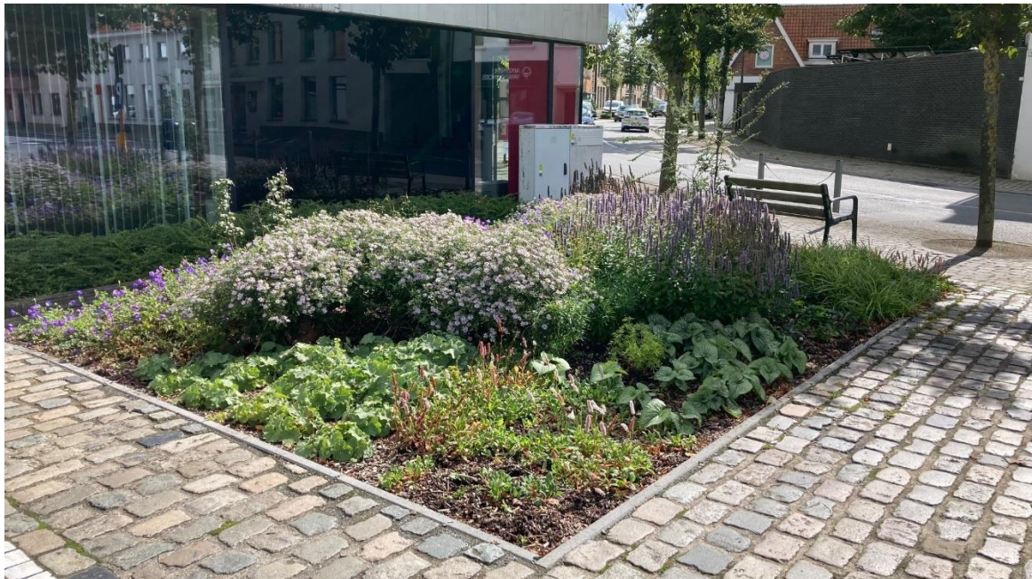
Figuur 28. Voorbeeld van een plantvak dat dienst doet als lokale infiltratievoorziening in de Stationsstraat in Jabbeke. © Aquafin
