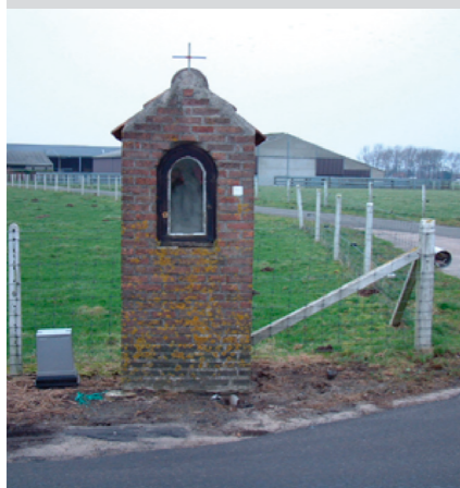
Een algemeen zicht op de kapel en haar omgeving. Ze is gelegen langs de weg maar heeft de ondergrondse elektrische leiding gevaarlijk dicht in de
