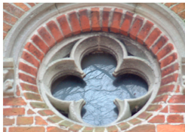
Het roosvenster dat zorgt voor daglicht in de kapel. In de andere muren zijn geen ramen aangebracht.
