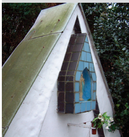
Een detailopname van de eigenlijke kapel in de nok.
